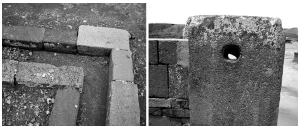
c) Canal de desagüe en el interior del templo
