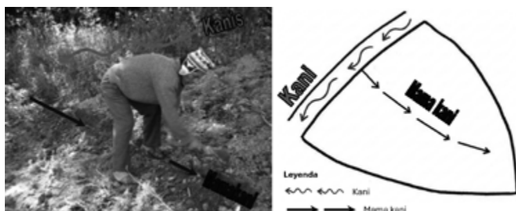
FIGURA 31. Paso 1. Miembro de la comunidad abriendo el mama kani , o camino al agua, en la parcela. También se muestra un esquema de cómo se va abriendo el mama kani desde el canal principal o Kani .
