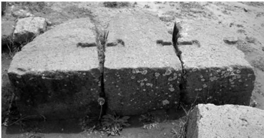
FIGURA 66. Bloques de piedra unidas por grapas en forma de T doble.
