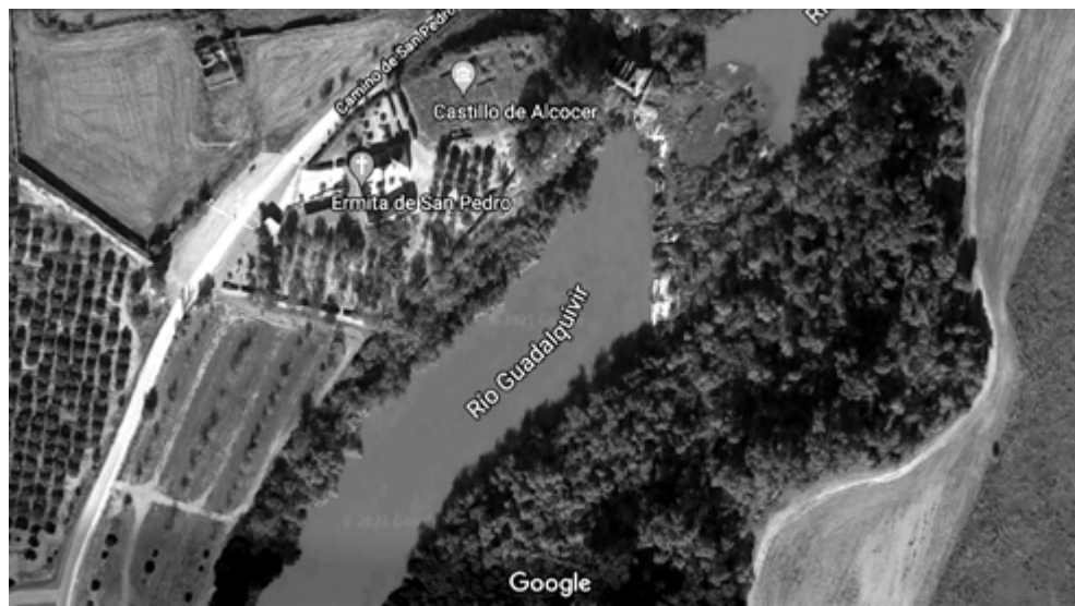
FIG. 1. Ortofoto del emplazamiento de la Ermita de San Pedro y asentamiento y fortaleza de Al-Qusayr (Alcocer). Fuente: https://www.google.es/maps/@37.9527892,-4.4957371,355m/data=!3m1!1e3?hl=es .
