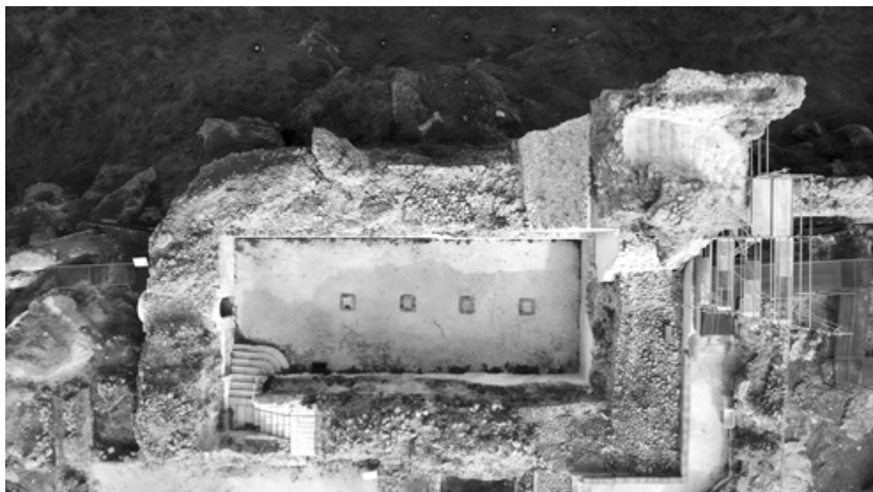
FIG. 3. Vista aérea cenital de los restos conservados de la torre del homenaje. Foto: Carlos Olmedo
