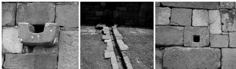
FIGURA 68. Detalles del templo Kalasaſaya : Sistema de desagües (izq.), Canalizaciones de agua de lluvia (centro) y Encaje de las piedras en las paredes (der.).
