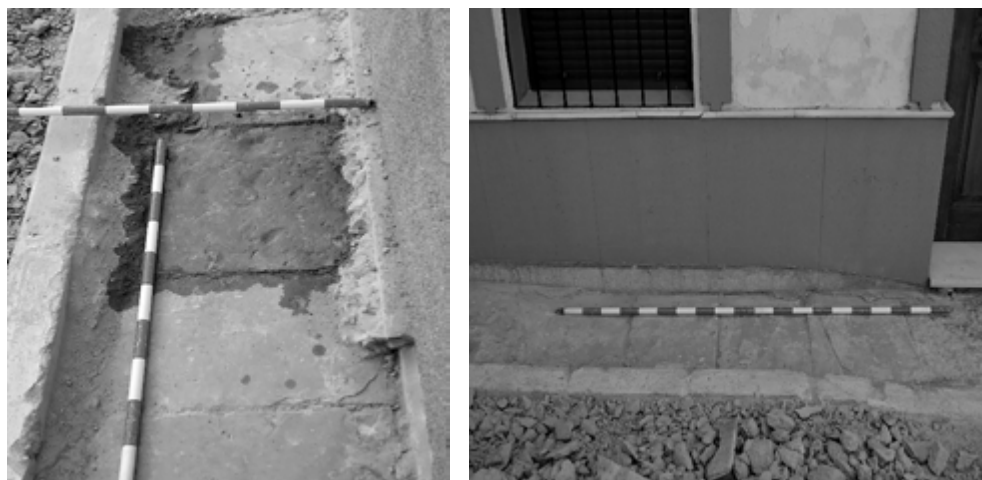
FIG. 3. Pavimento de lajas de piedra de finales del siglo XIX y/o primera mitad del siglo XX descubierto en calle El Santo bajo el acerado actual (El Carpio, Córdoba)). Fuente: J. López Rider
